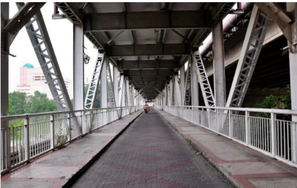
JAMBATAN Kota atau juga dikenali sebagai Jambatan Dua Tingkat mula dibuka pada 1957 bagi mengurangkan kesesakan lalu lintas di Bandar Klang. - Foto Abdul Jabar Idris
